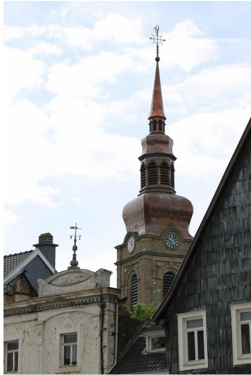
Ansicht Kirchturm St. Nikolauskirche
